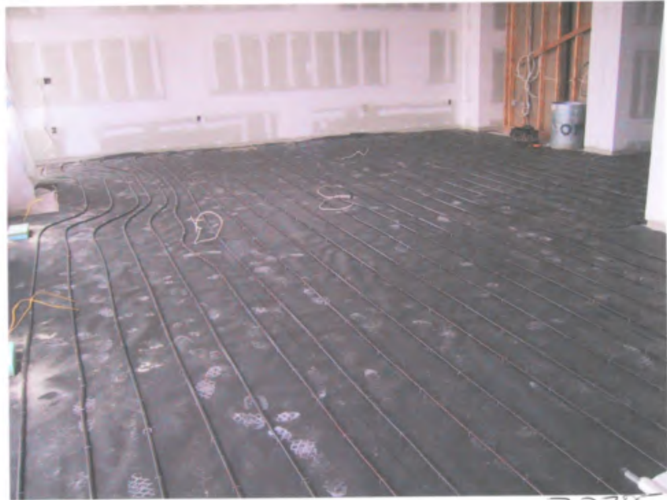
Pcy floor wat before thin slab pour 22705
